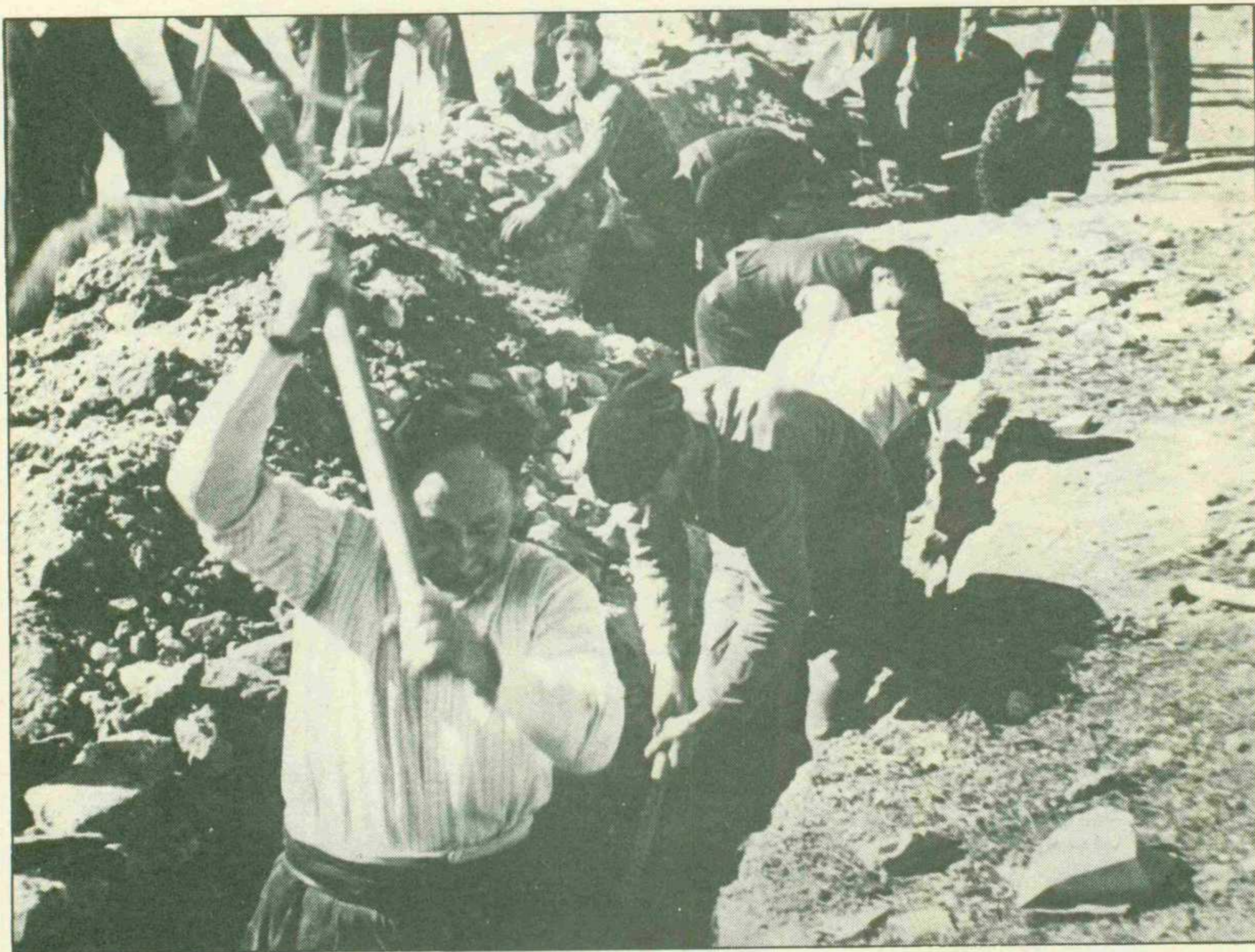
«En la mañana del 8 de noviembre —escribe Lister—, las columnas enemigas iniciaron el avance, pero chocaron con una resistencia organizada», uno de cuyos primeros pasos sería este excavamiento de trincheras.
